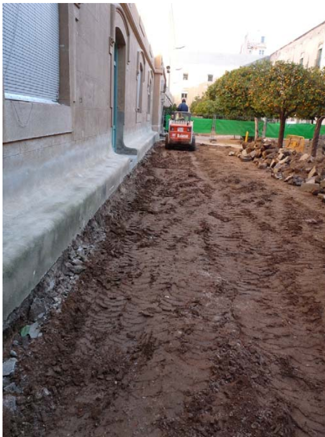
Foto 4, vista de la cota final del rebaix en el sector sud-oest.
