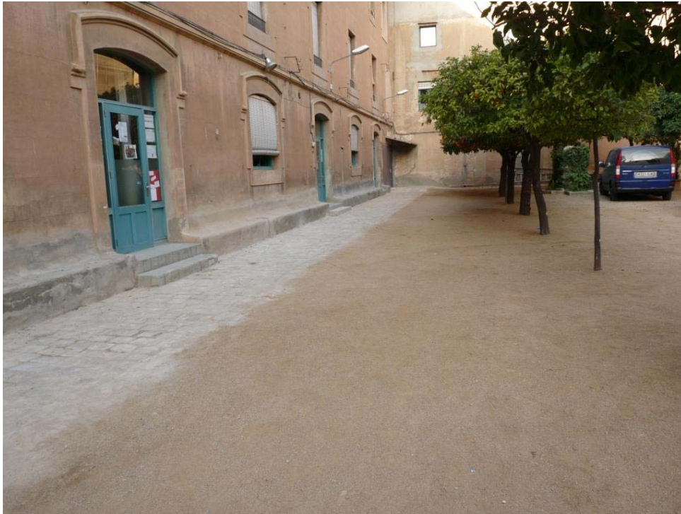
Foto 13, vista del Pati dels Tarongers un cop acabada la nova urbanització.
