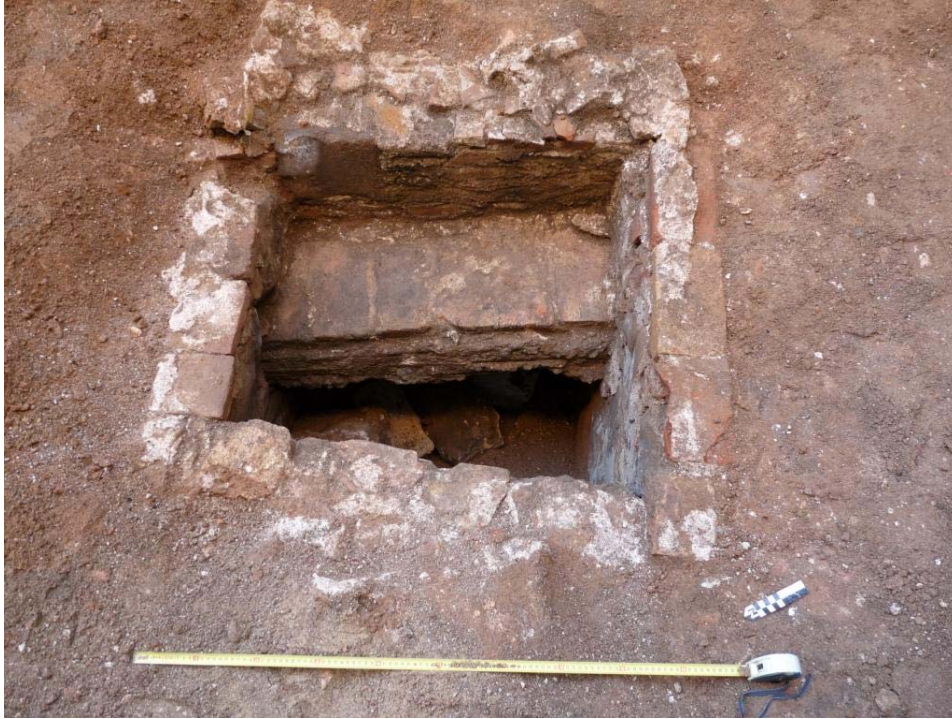
Foto 3, vista de la claveguera que creua la fossa sèptica.
